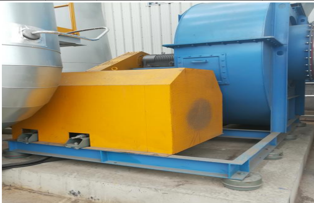
图 4.4 风机减震基座
