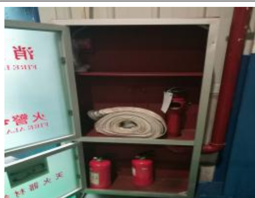
图 4.7 消防栓及灭火器
