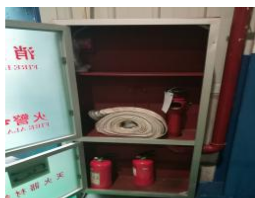
图 4.7 消防栓及灭火器
