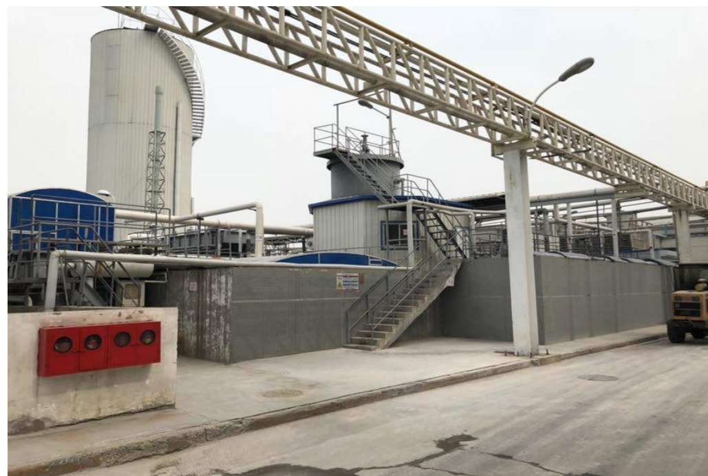
图3.生产污水处理站
