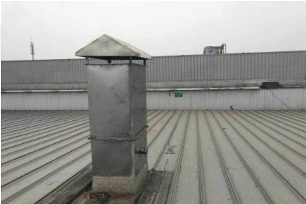
图 1.本项目废气排气筒
