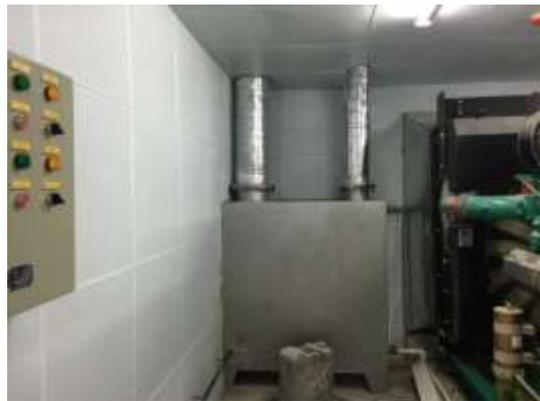
发电机废气处理装置
