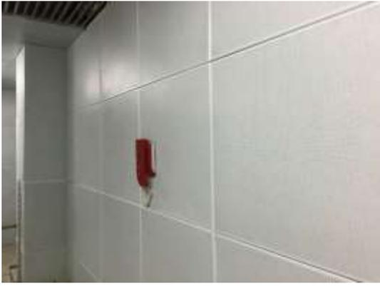
发电机房隔声墙
